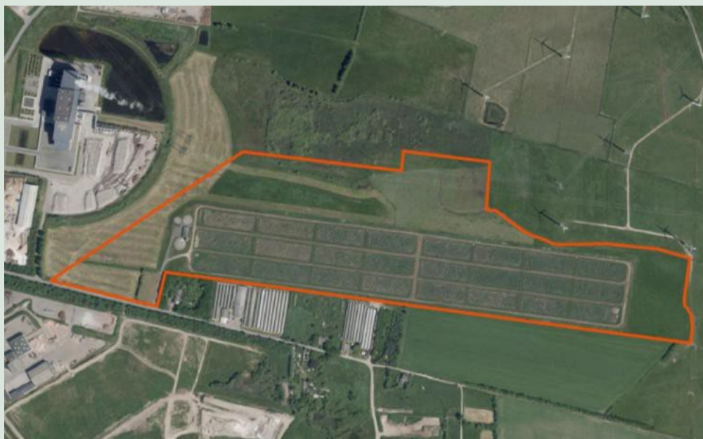
FIGUR 12. Anlægget til slammineralisering med 24 slambede hos DIN Forsyning i Esbjerg.
