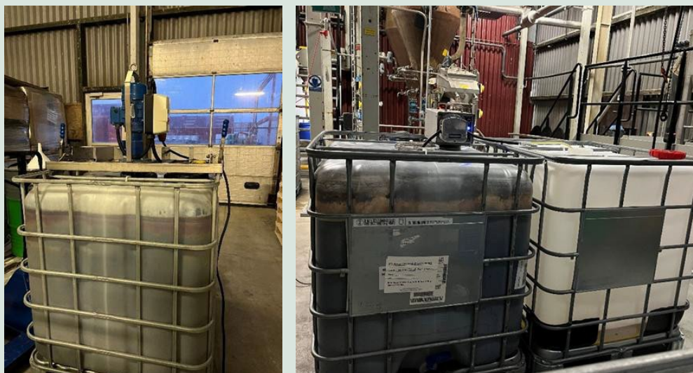
FIGUR 49. Kulbehandling og flokkulering af P3-afværgvand (1) Forsøgstank med omrøring og (2) Forbehandlet P3 pumpes fra forsøgstank til ren palletank.
