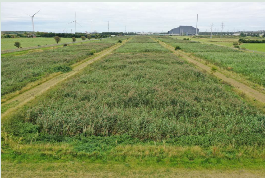
FIGUR 13. Slambedene hos DIN Forsyning i Esbjerg.
