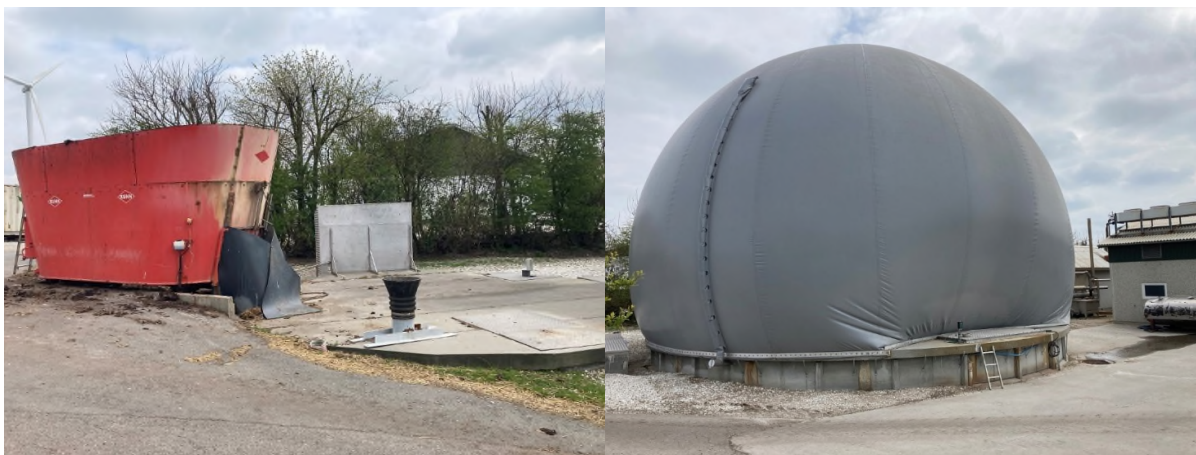
Foderblander og mixertank til indfødning af fast biomasse i Skinnerup Biogasanlæg. Foderblanderen er monteret med vejeceller (venstre). Kombineret gyllefortank og gaslager på Skinnerup biogasanlæg (højre).
