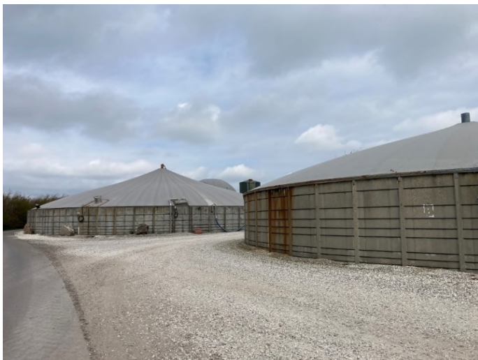
Skinnerup Biogasanlæg. I baggrunden ses den første af de to serieforbundne reaktortanke og i forgrunden den anden reaktortank.
