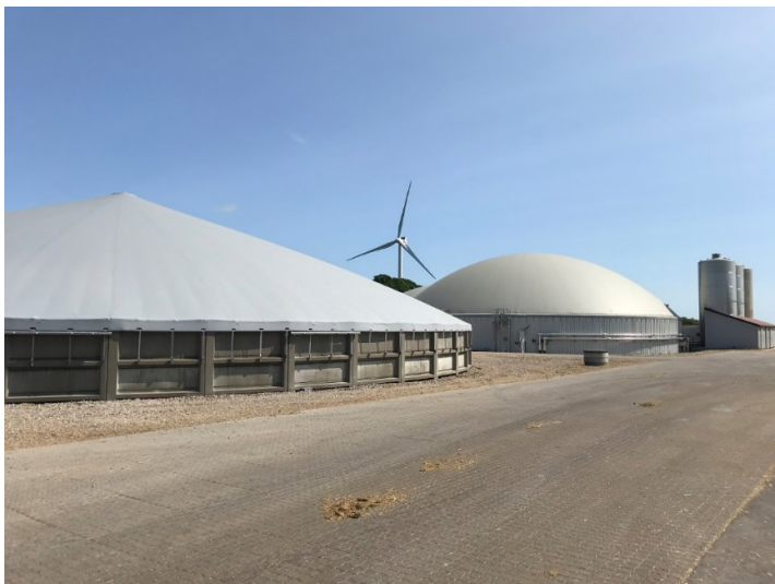
Ausumgaard Biogas. Forest en uopvarmet sekundær rådnetank, der er forbundet til en opvarmet reaktortank i baggrunden. Desuden ses tanke til glycerin eller anden flydende biomasse.
