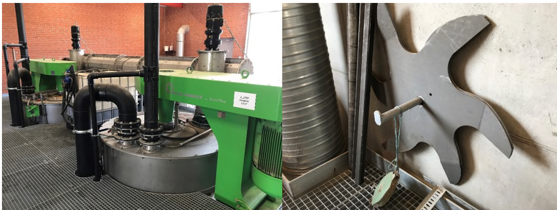
To Envitec-dissolvere à 4,5 m 3 til opblanding af fast biomasse i gylle og recirkulat. Til højre ses nye stjerneknive, der sikrer omrøring og delvis neddeling i dissolverne.
