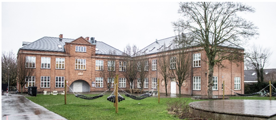
Figure 3 Borgerskole Nordbygning (Vinkelbygning).
