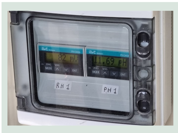
FIGUR 13. Kontinuerlig måling af ORP (i mV) og pH i det første trin af oxidationsprocessen. Målingerne sendes videre og bruges til automatisk styring af anlægget.
