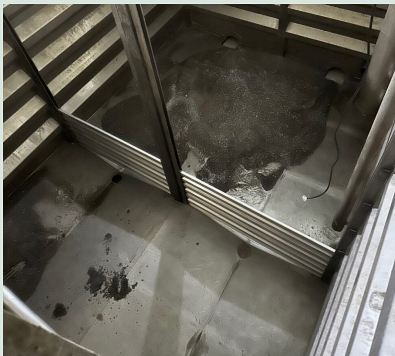
FIGUR 4. Gammel "buffertank" modificeret med skilleplader, så sand og øresten kan bundfældes, og derved ikke ledes ind i flotationsårnene.
