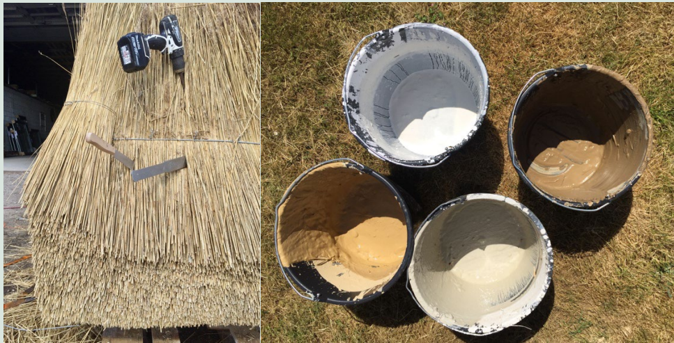
FIGUR 1. Tv. Lodret tækning udført ved Tækkedagen i Glamsbjerg, sept. 2019.
