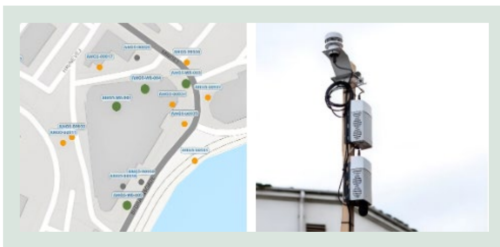
FIGUR 47. Placeringen af alle de installerede sensorer på projektet, inklusive støjsensorerne, der er markeret med grønne cirkler (billede til venstre), og en tættere visning af Airnode-sensorerne installeret i projektet til overvågning af støj- og emissionsværdier (billede til højre).
