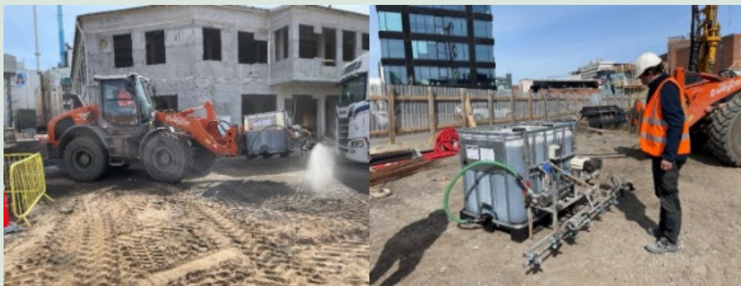
FIGUR 22. Spredning af DustAway 1 maj 2023. Til højre ses tanken med DustAway. Til venstre ses spredningen i aktion.
