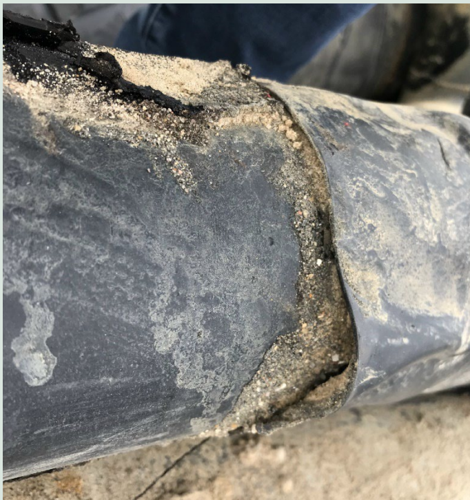
FIGUR 77. Rørsamling med klister/bitumen og krympeflex (L9).
