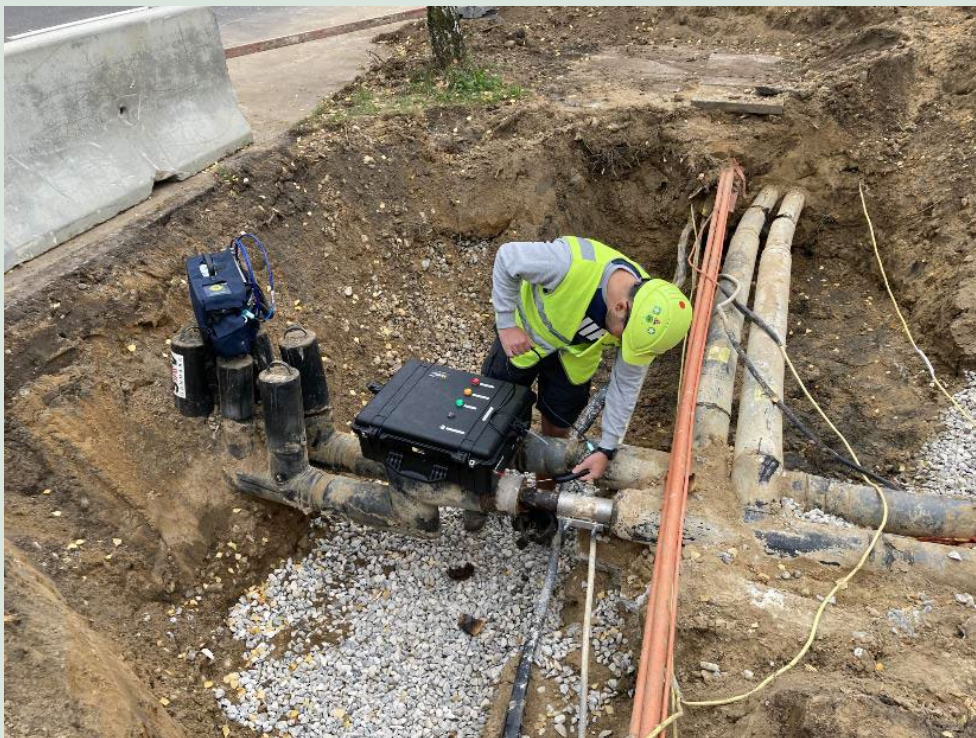
FIGUR 18. Test af den videreudviklede CFC-sensor i samarbejde med Dan Jord ved en opgravning ifm. en reparation af fjernvarmerør.
