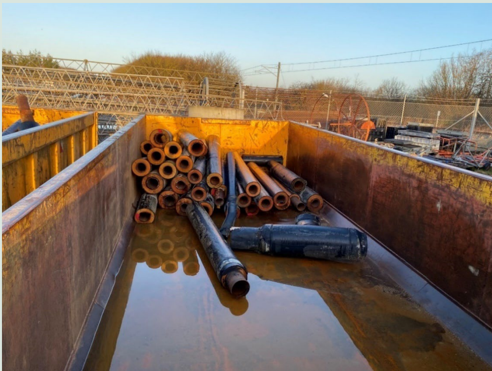
FIGUR 29. Type 4: Frasorterede rør med CFC.
