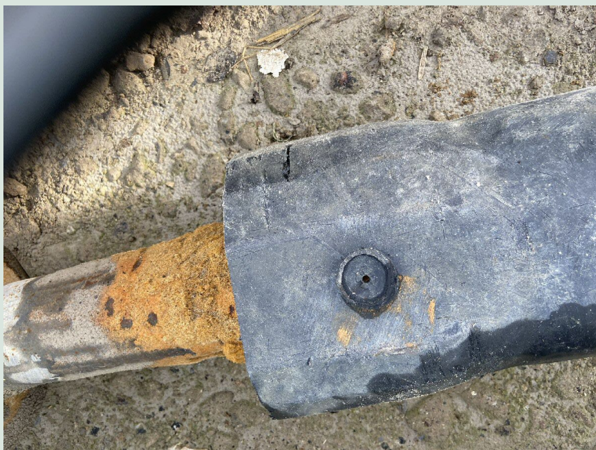
FIGUR 82. Indblæsningshul med sort plastprop (M5).
