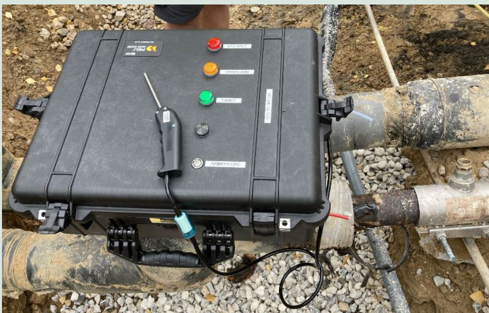
FIGUR 19. Test af den videreudviklede CFC-sensor i samarbejde med Dan Jord ved en opgravning ifm. en reparation af fjernvarmerør.
