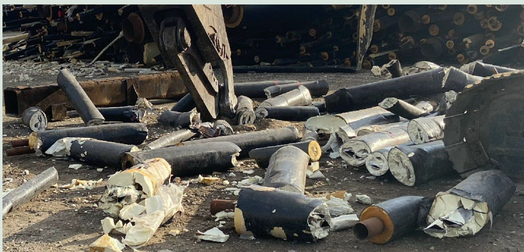
FIGUR 9. Neddeling af fjernvarmerør med næbsaks.
