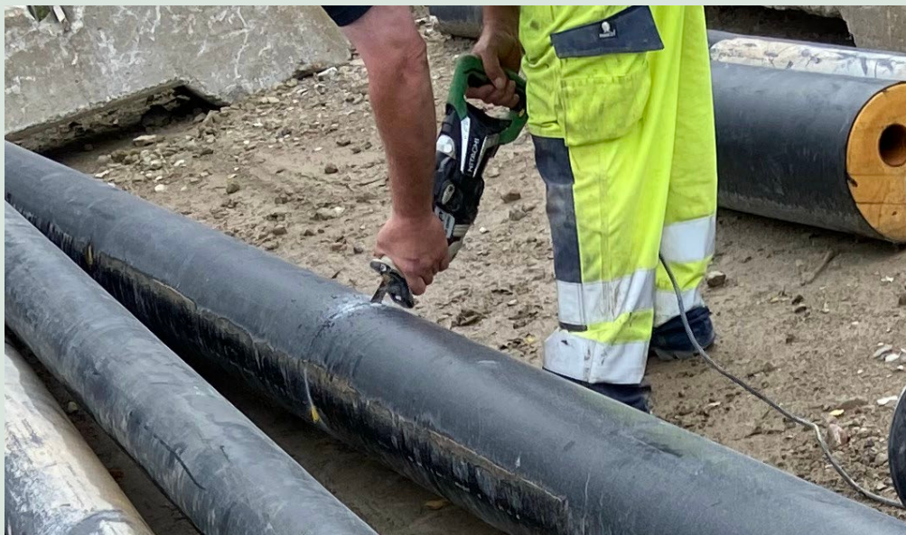
FIGUR 25. Neddeling med bajonetsav.
