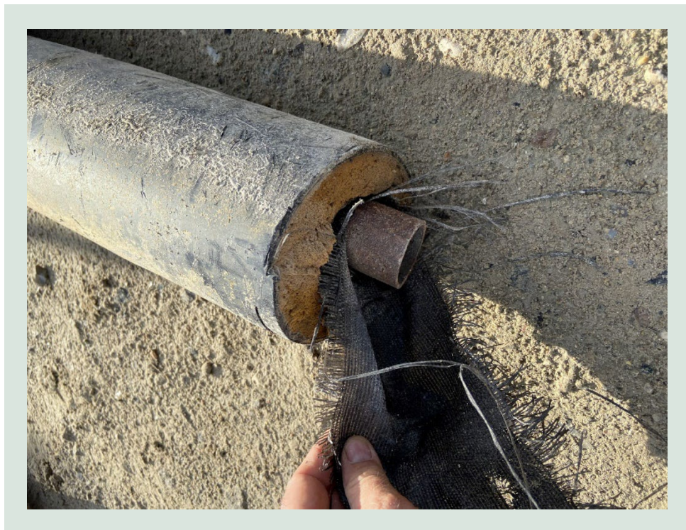
FIGUR 69. Tekstillærred (PP) op ad medierør (L1).
