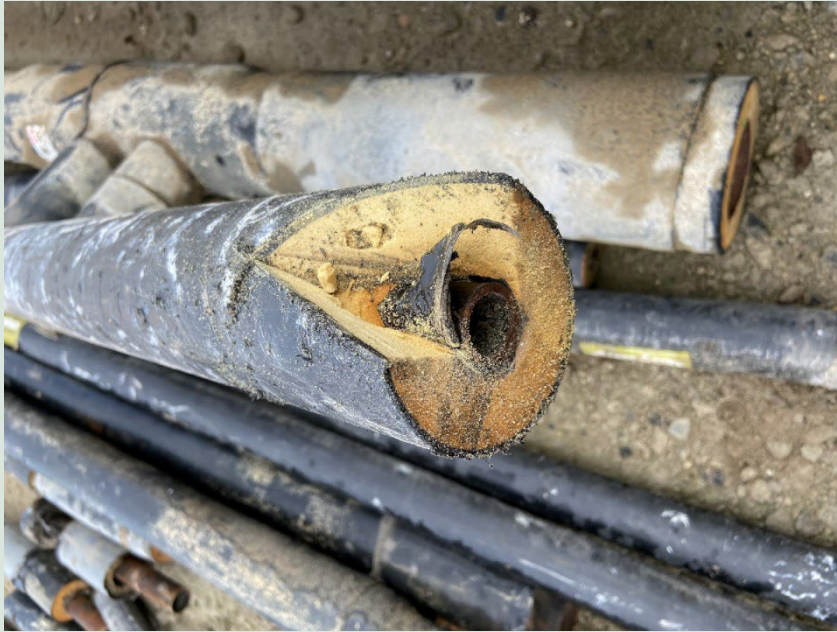
FIGUR 72. Bitumen/klisterlag op ad medierør (L4).
