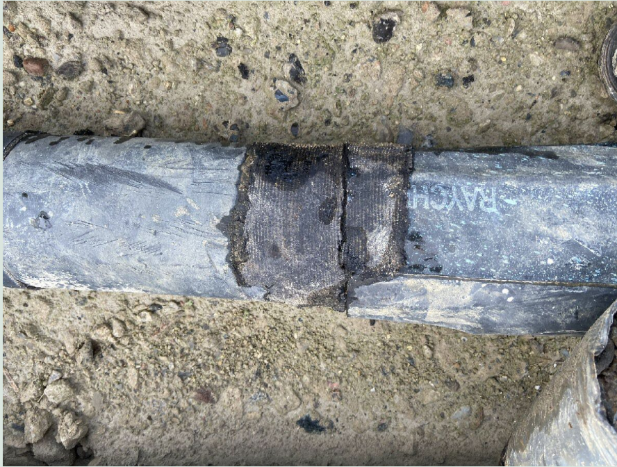
FIGUR 76. Samling af rør med lærred (PP) og bitumen/klister (L8).
