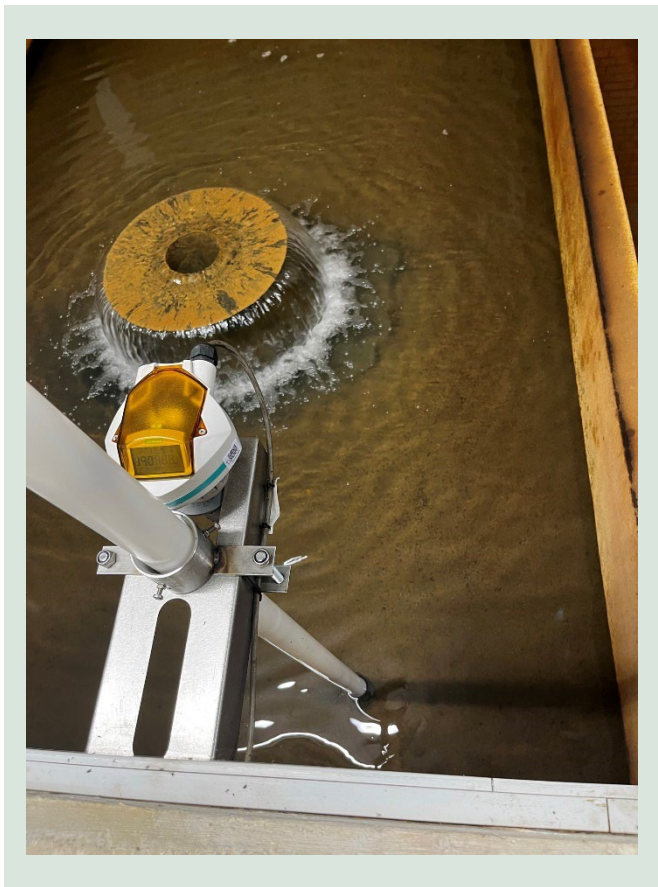
FIGUR 12. Billede af BET sensoren opsat på Tolne Vandværk. BET sensoren monitorer fluidisering af filtermedie under returskyllet.
