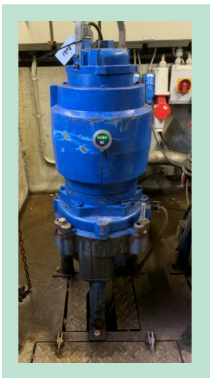
FIGUR 10. EWA sensor monteret på vertikal pumpe.
