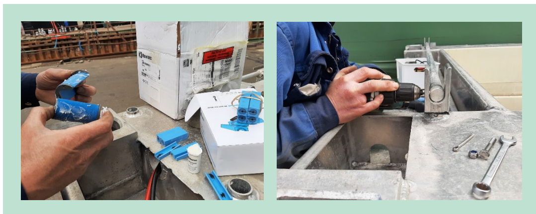
FIGUR 16. Roxtec kabelgennemføring monteres (venstre). Gaffelsystem til fastgørelse af skimmer (højre).
