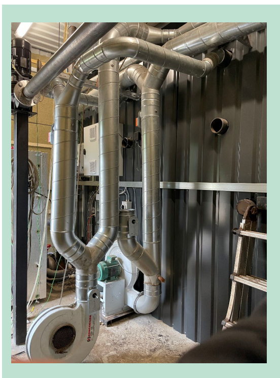
FIGUR 24. Blæsesystem for uafhængig luftstyring (bagside af kedlen).
