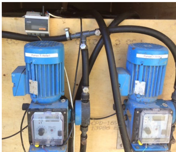
FIGUR 10: Doseringspumper til jernklorid med installeret styringsenhed (øverst til venstre)
