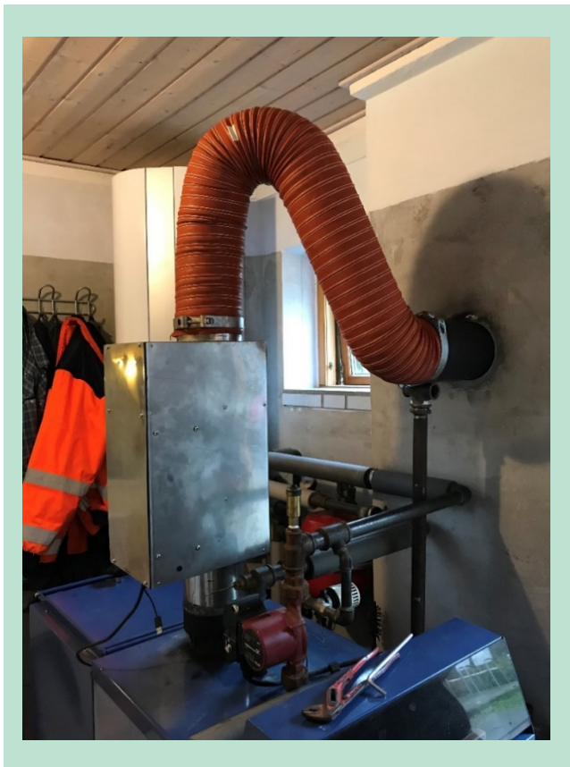
FIGUR 8. Partikelfilter indsat i stedet for røg rør.
