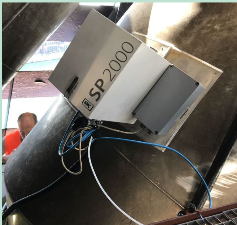
FIGUR 13. Fortyndingsproben er installeret på en ca. 45 graders rørbøjning, så det ikke risikeres at indstiksrøret leder scrubbevand ind i filtret.
