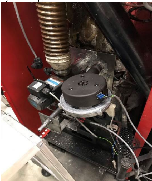
Sekundærdyse monteret med højtryksblæser
