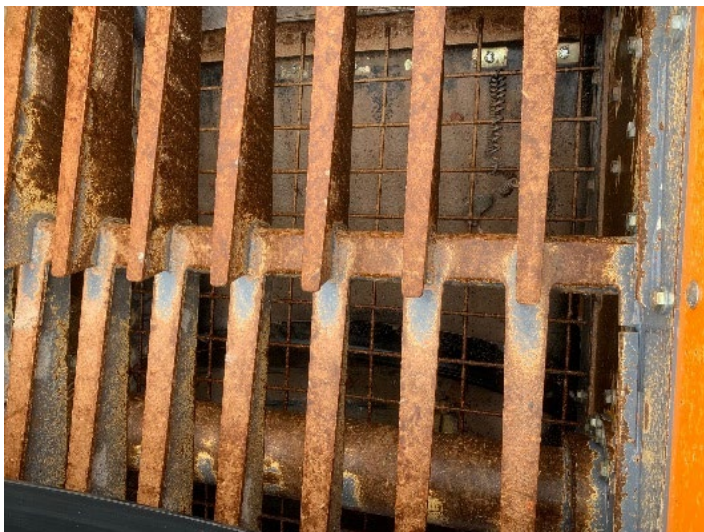
Figur 6: Oversoldet i anlægget sørger for at de hele og halve mursten sorteres fra. Det nederste sold på billedet er 0-800 mm
