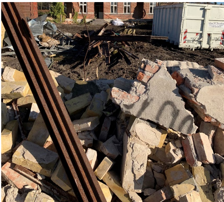
Figur 13: Eksempel på nedrivning, hvor fraktionerne er blandet
