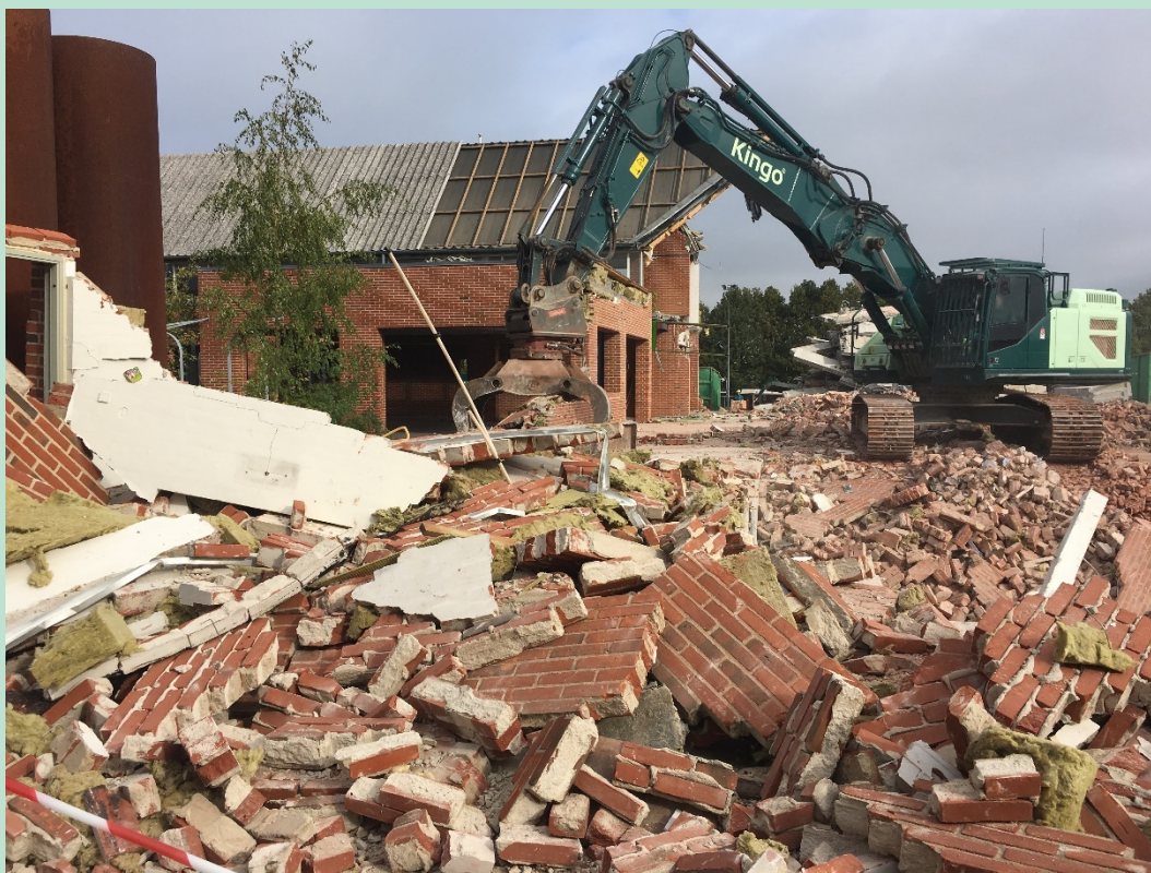
FIGUR 19. Billede fra nedrivning af murværk, Skejbyvej Aarhus.
