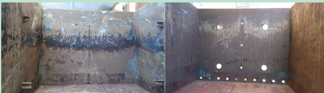
FIGUR 8. Jordbehandlingscontaineren indvendig efter pilotforsøget. Enden væk fra luftindblæsningen (venstre) som var længst tid om at tørre ud har overfladiske korrosionsskader. Enden med luftindblæsning som tørrede hurtigst ud er stort set upåvirket (højre).
