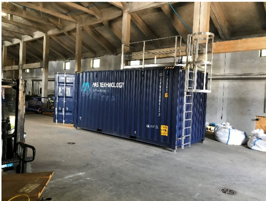
FIGUR 3. PAS-2 opstillet på Islevbro Vandværk. Pilotanlægget var monteret i en isoleret standard High Cube 20' container tilsluttet til vandværkets trykforøger og med afløb til Harrestrup Å (0,5 – 3 m 3 /time).
