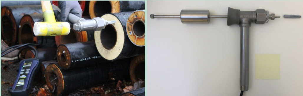
FIGUR 11. Anvendelse af nylonhammer (til venstre) eller slaglod (til højre) til at hamre proben ind i skummet.
