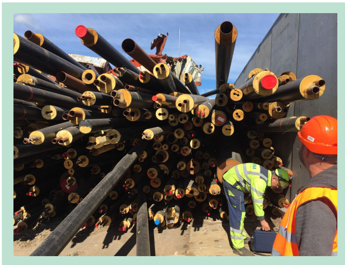
FIGUR 21. Midlertidig opbevaring af fjernvarmerør hos Stena Recycling.
