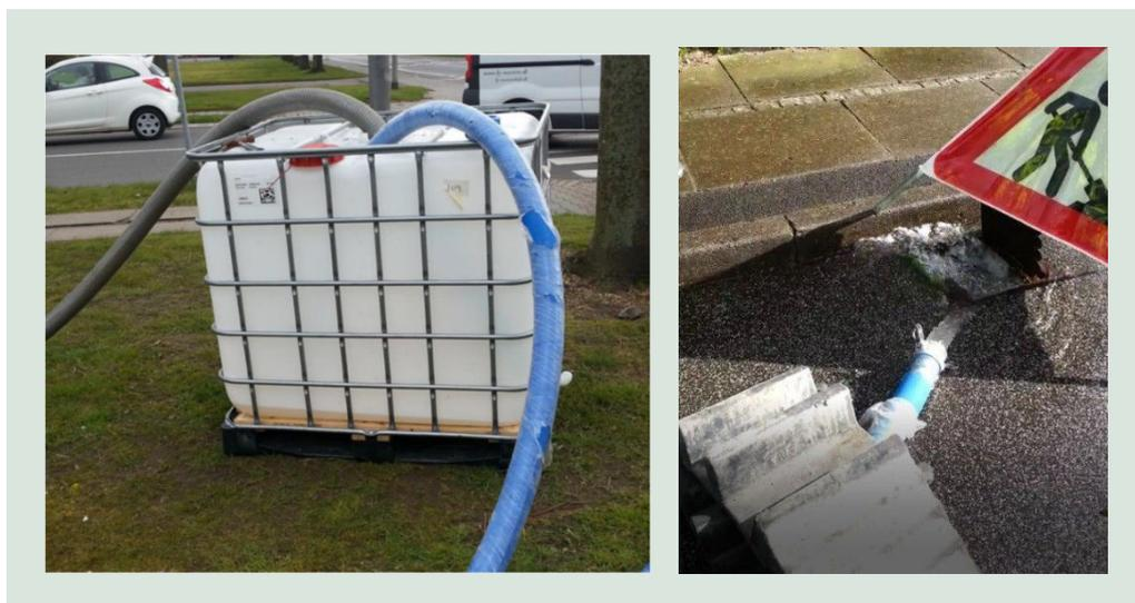
**FIGUR 3.** Til venstre: Midlertidig opsamlingstank til udløbet med afløbsslangen vand vandledningen (blå) og tømningsslange til slamsuger (grå), Venusvej. Til højre: afledning til kloak, Esagervej.
