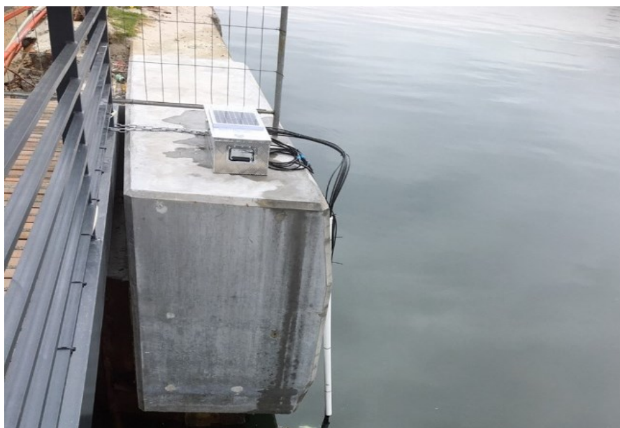
FIGUR 7. Testopstilling af automatisk prøvetager til udtagning af prøver i forskellige dybder.
