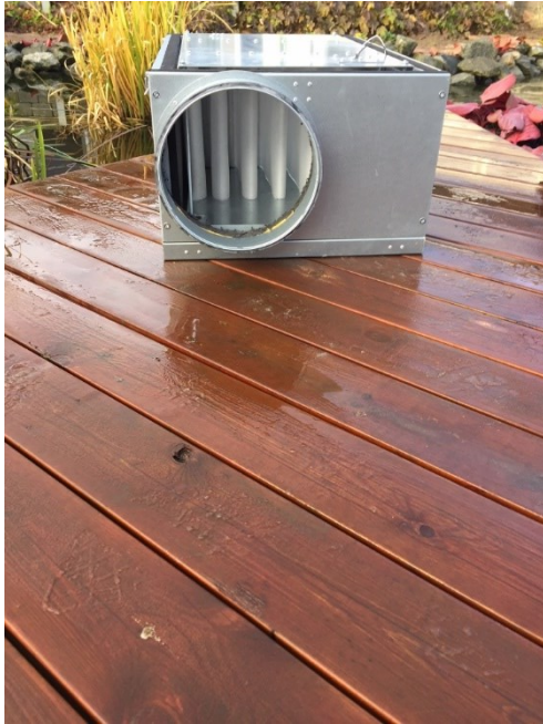
Figur 9. Nyudviklet automatisk filterløsning. Kan fungere 5-10 år uden driftsmæssige indgreb. Mulighed for kombination med elektrostatiske filter for fjernelse af helt små partikler.
