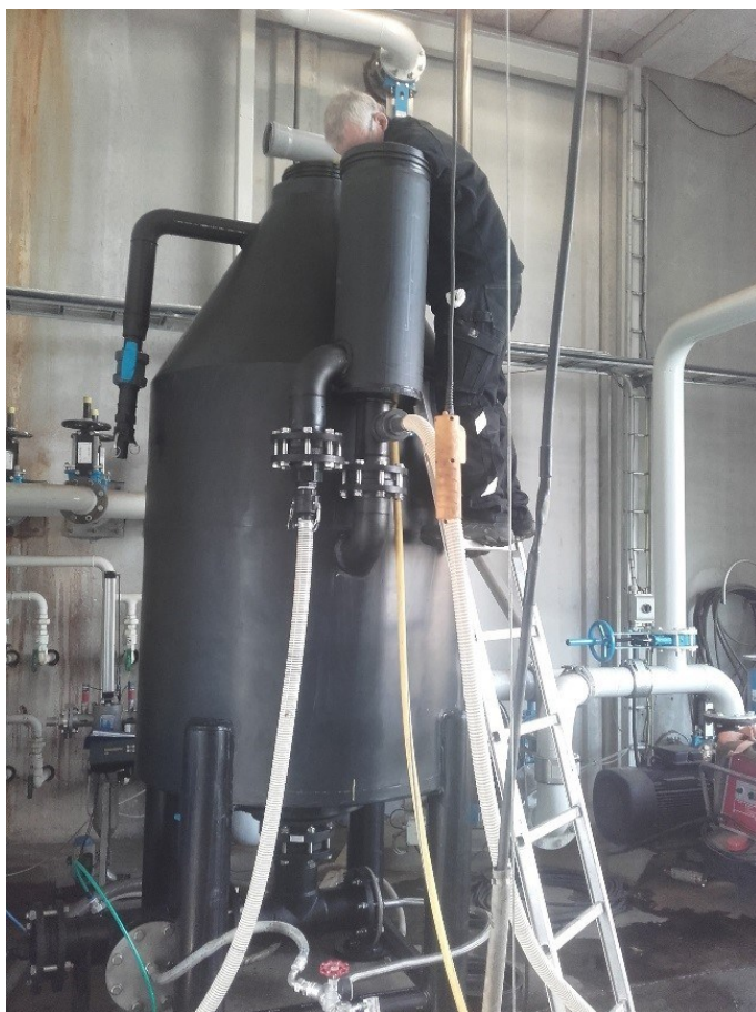
Billede 8 Implementering af det reviderede, kegleformede flotationsanlæg.
