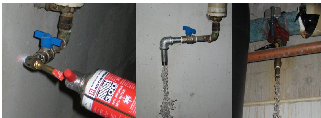
FIGUR 3-1 PRØVETAGNING PÅ HOVEDLEDNINGEN VED OPGANG 2 OG 3 I CENTRALKOMPLEKSET. TIL VENSTRE SES BRÆNDING AF HANEN INDEN PRØVETAGNING, I MIDTEN SES HANEN VED OPGANG 2 OG TIL HØJRE SES HANEN VED OPGANG 3.
