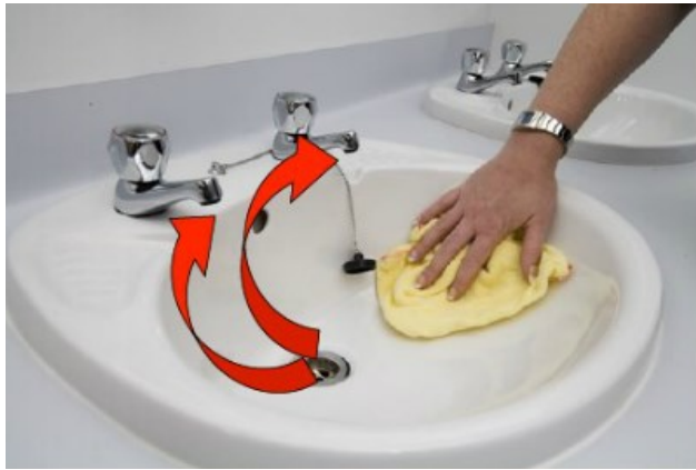
FIGUR 4-3 UHENSIGTMÆSSIG RENGØRINGSRUTINER, HVOR BAKTERIER FRA AFLØBETS BIOFILM SPREDES TIL VANDHANER [66]
