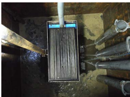
Figur 3. Undersøgelse af MBR filter efter stresstest. T.h. ses DeOx anordning.
