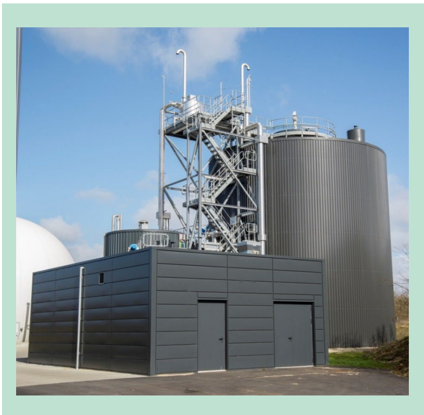
FIGUR 8. Den nye rådnetank med den nye maskinbygning i forgrunden.
