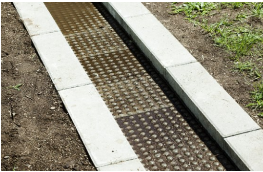
BILLEDE 7 STOR VANDRENDE MED FORSKELLIGE FLISER I BUNDEN
