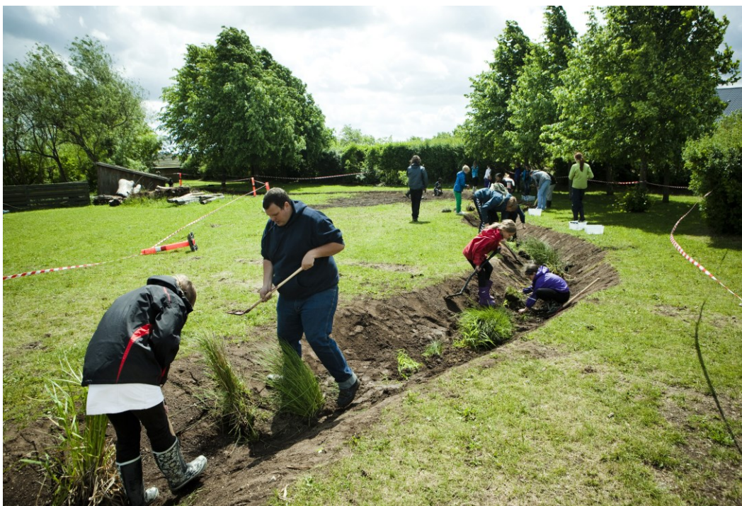
FIGUR 14 BEPLANTNING AF GRØFTEN, DER FUNGERER SOM OVERLØB TIL REGNBED (FOTO: THOMAS WILHELM, SPECIALPHOTO).
