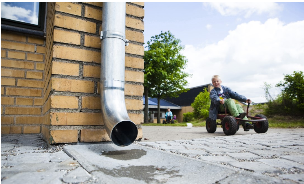
FIGUR 7 RUND VANDRENDE FRA IBF TRANSPORTERER TAGVANDET TIL DE STORE VANDRENDER (FOTO: THOMAS WILHELM, SPECIALPHOTO).
