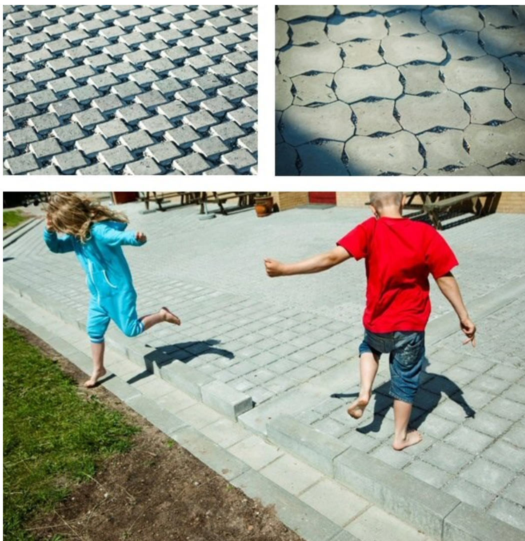
FIGUR 6 IBF OG NCC HAR MODTAGET DI BYG'S INNOVATIONSPRIS 2013 FOR DE PERMEABLE BELÆGNINGER. ØKOLOCK (ØVERST TV) OG ØKOSUPERLOCK (ØVERST TH) OG RIMA (NEDERST) ER DEMONSTRERET PÅ KLIMASKOLEN (FOTO: THOMAS WILHELM, SPECIALPHOTO).
