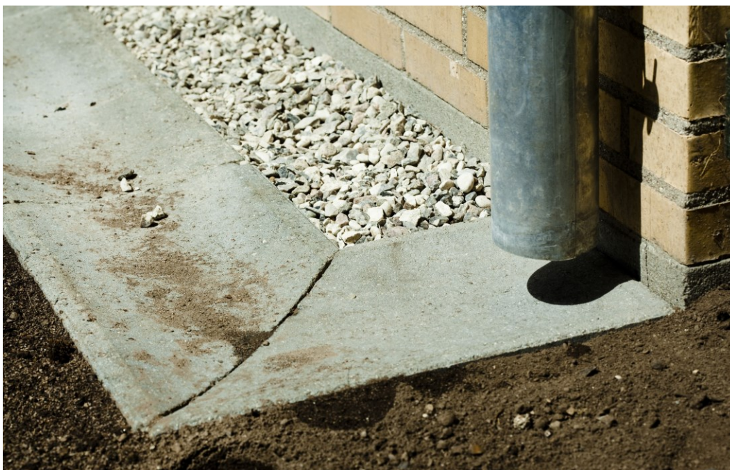
FIGUR 8 90°S VINKLER I RUNDE VANDRENDER BØR UNDGÅS. TAGVANDET LØBET UD OVER KANTEN OG ERODERER OMKRINGLIGGENDE JORD.
