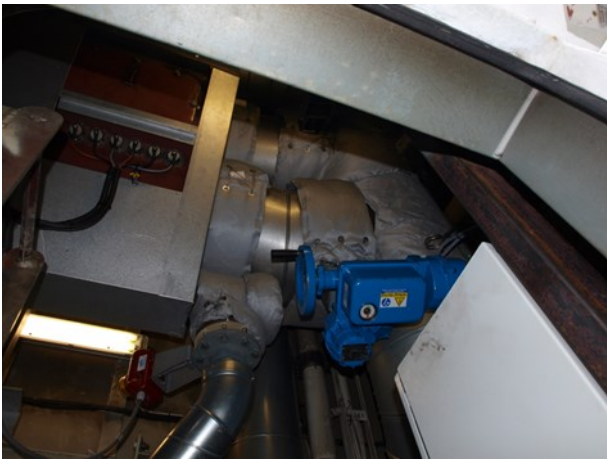
Figur 11: Automatisk røggasspjæld og tilhørende styretavle.
