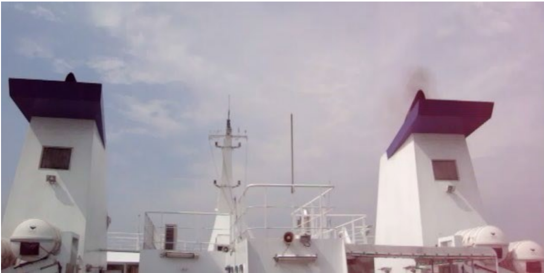
Figur 22: Havnemanøvre med indkoblet partikelfilter i bagbord side (t. venstre). Der ses en tydelig røgfane fra skorstenen i styrbordsside hvor der ikke er monteret kombinationsløsning.
