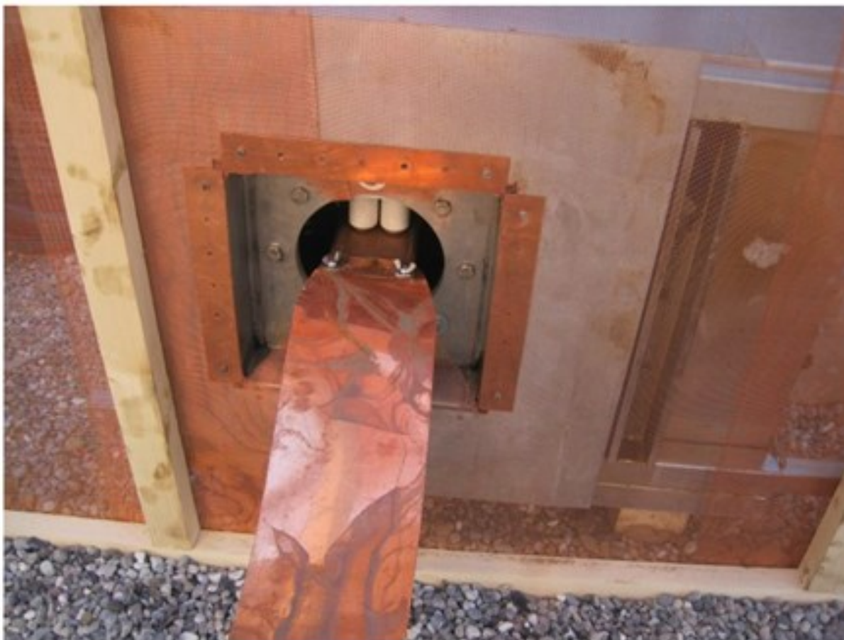
Foto nr. 2. Foto af tilslutning mellem matchbox og antenne.
