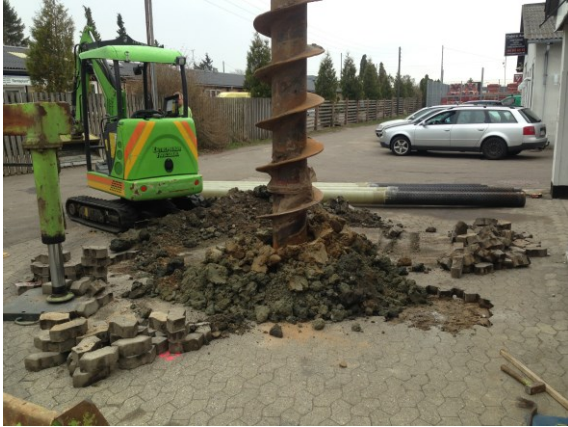
Foto nr. 5 Boring til antenne
