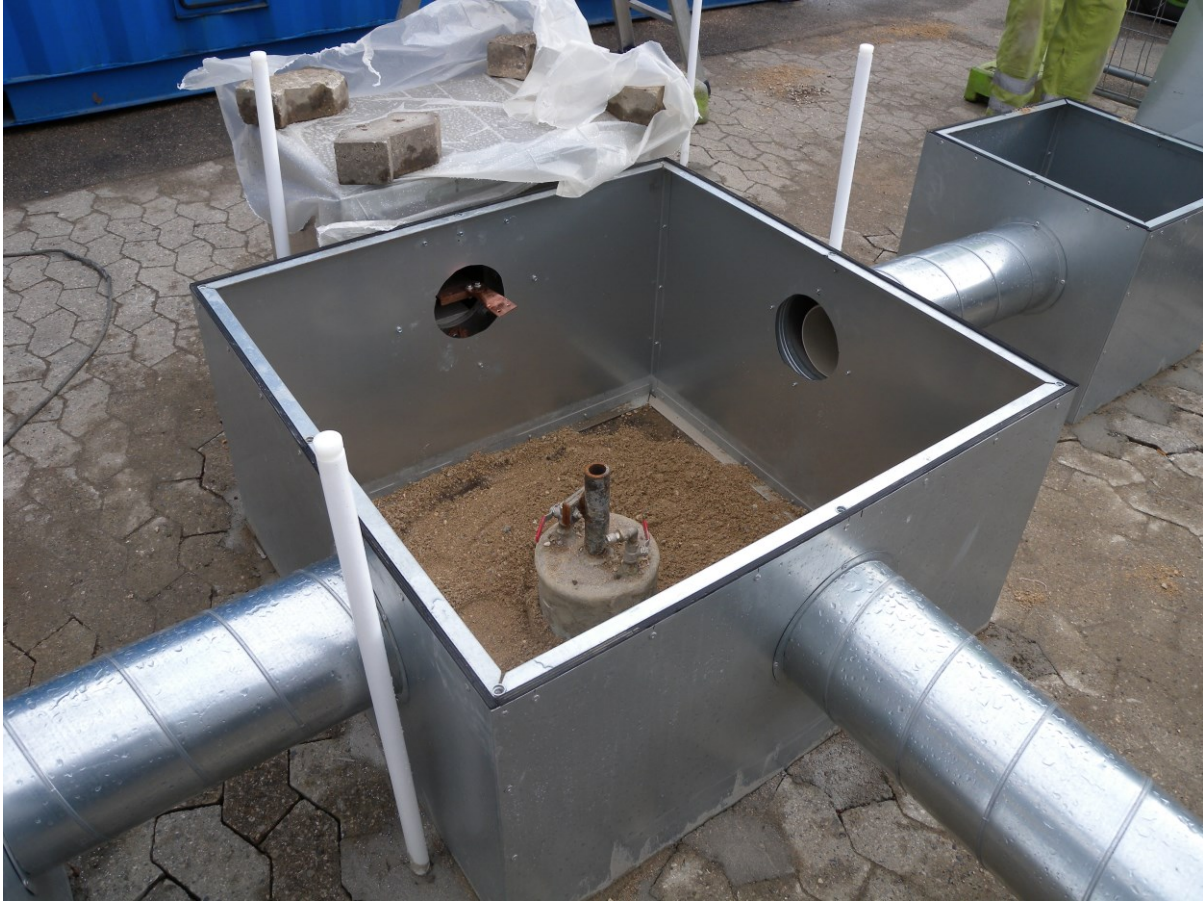
Foto nr. 7. Afskærmning af antenne (Faradays bur) vist med låget taget af.
