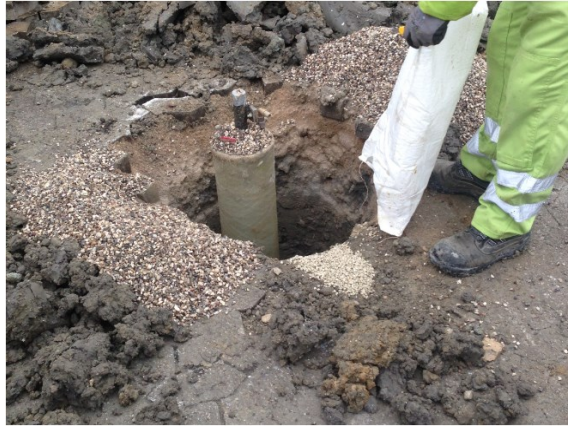
Foto nr. 6 Gruskastning af antenneboring
