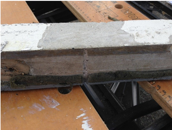
FIGUR 18: SERIE 2. BETONEMNE MED RESTER AF FUGE.
