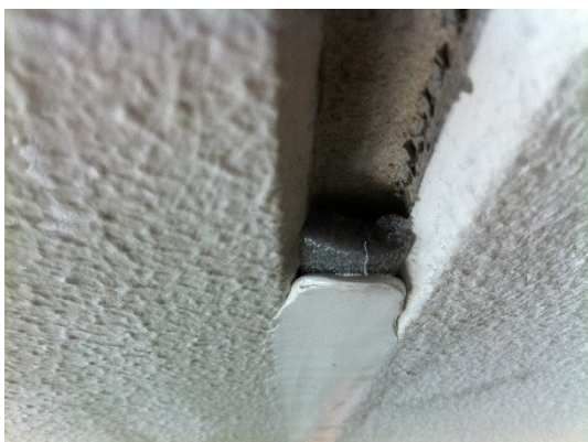
FIGUR 9: LODRET DRÆNKANAL ILAGT FUGEBAKSTOP OG NY FUGE.
