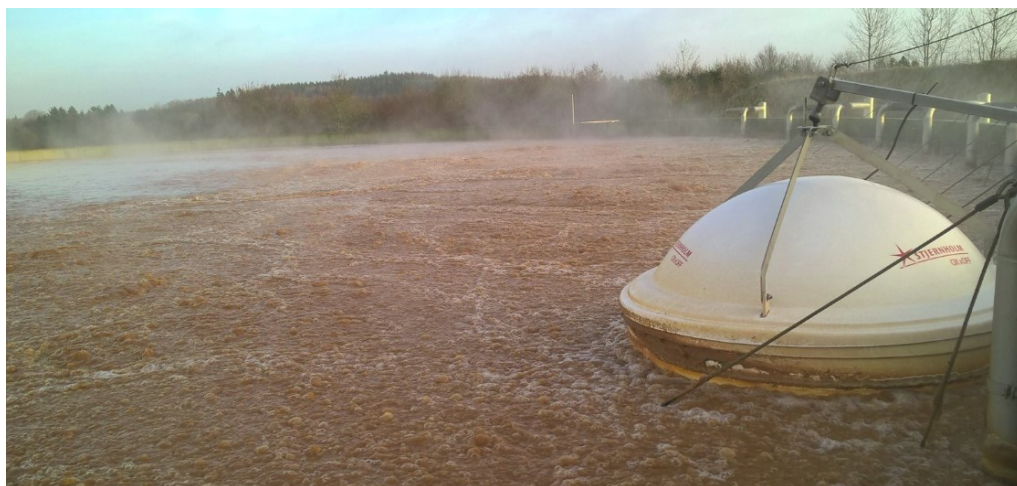
Figur 23. Billede af offgas-måler placeret i en kraftig beluftet tank, hvilket ses af større bobler og urolig overflade med mindre tendens til "paddehatte" og turbulente områder, hvor vandet løftes.
