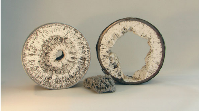
Figur 5.1 Ukontrolleret struvitudfældning i rørledninger på renselanlæg
