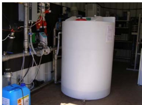
Figur 102: 1 m 3 reaktionstank med forfilter, flowmåling og rørinstallation.
