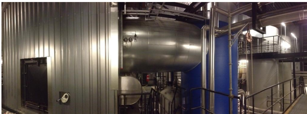
FIGUR 17 FOTO AF BIOMASSE OVN, KEDEL (BLÅ), QUENCH OG SKRUBBER.
