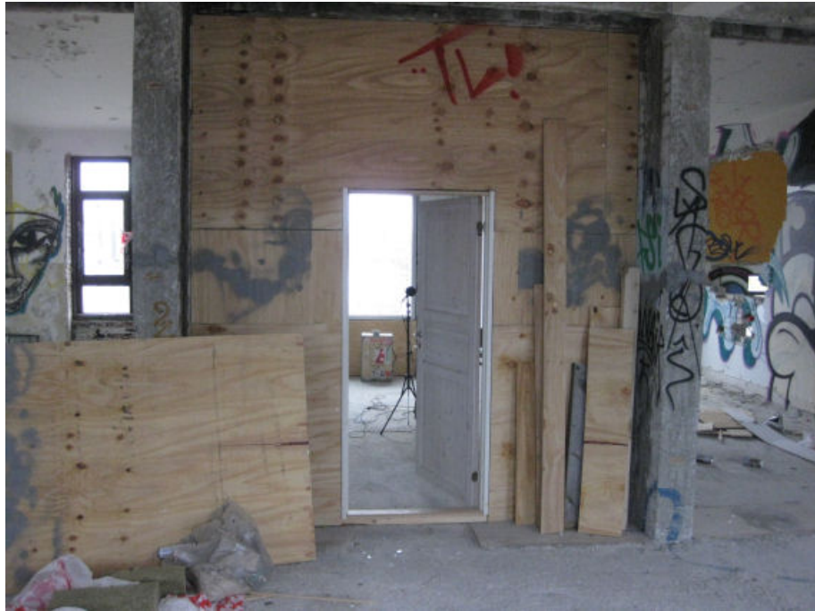
Billede 1 Mock up opbygning set indefra Konstabelbygningen
