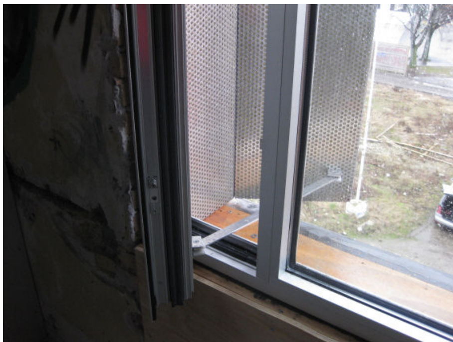
Billede 5 Vindue med delvist åbningsareal på 0,35 m 2 . Skodde og Vindue står 45 grader i vinkel på fast vindue
