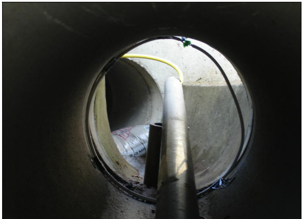
Ø500 beton med indvendig antenne og tag-passage i centrum af røret
